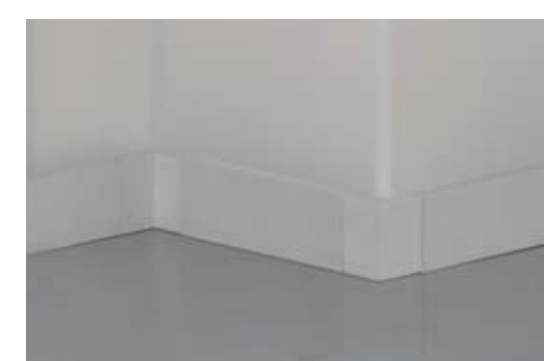
Battiscopa minimale altezza cm. 4 con angolari Minimal baseboard (h. 4 cm) with metal corner beads
